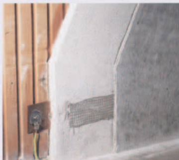
6 Abschirmputz auf Gipsbasis mit Karbonfasern. (Foto: Knauf)
