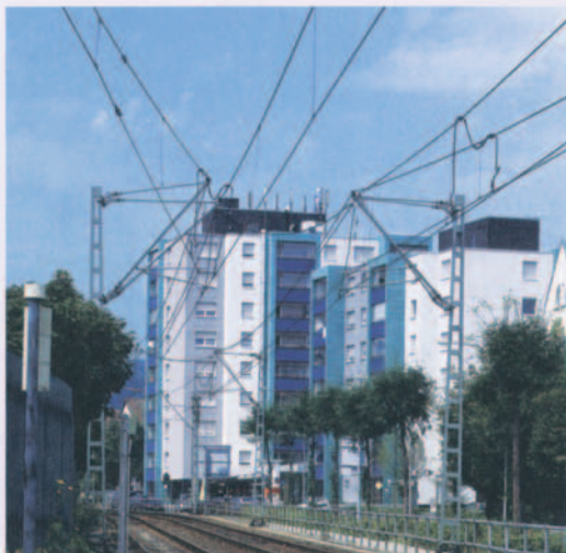
3 Dieses Wohngebäude in Oberursel erhielt eine Fassaden- dämmung mit Schutz vor Elektrosmog.
