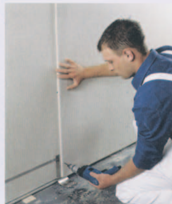
8 Bei der La-Vita-Abschirmplatte sorgt ein Ableitblech für den Potenzialausgleich. (Foto: Knauf)
