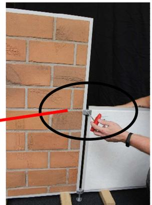
14. Auf diese Weise werden die ersten fünf Tafeln miteinander verbunden, solange sie noch in den Aufbauschuhen stehen. Dann werden die Aufbauschuhe der ersten drei Tafeln abgebaut. Dazu den unteren Klotz nach vorne wegziehen, so dass der geschlitzte Klotz nach unten wegfällt.
