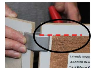
12. Nachdem die ersten beiden Tafeln miteinander verbunden sind (i.d.R. zwei vertikale Platten), erfolgt nun der Anschluss der Tafel 1.3 nach bekanntem Verfahren. Zunächst wieder den Stellfuß montieren.
