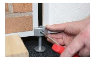
13. Zum Verbinden einer horizontalen mit einer vertikalen Tafel wird der Verbinder auf der Höhe des oberen Endes des Putzmusters montiert. Auch hier wieder beide Platten auf Anschlag in die Aufnehmer des Verbinders schieben. Besonders zu Beginn auf sauberen Sitz der Tafeln achten, weil sich Fehler im weiteren Verlauf verstärken können. U.U. den einen oder anderen Verbinder nochmals lösen und nachjustieren.
