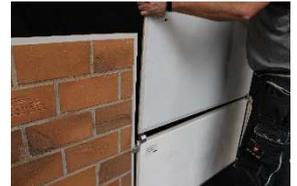
21. Sobald die Tafel vertikal fluchtrecht positioniert ist, wird der linke horizontale Verbinder angezogen.
