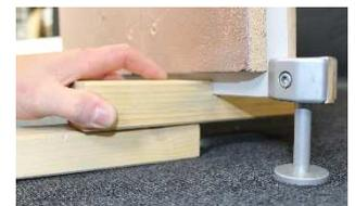
5. Auf diese Weise werden die ersten fünf Tafeln mit den Aufbauschuhen unterbaut.
