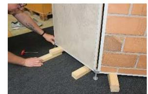
15. Die Aufbauschuhe der ersten drei Tafeln werden für das Platzieren der nächsten drei Tafeln wieder in Position gebracht, die Tafeln in die Schlitze gestellt und wie bekannt verbunden. Für die letzte Tafel der ersten Reihe das erste Paar Aufbauschuhe entfernen und entsprechend positionieren (Staffelprinzip).
