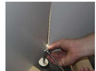
11. Die beiden Tafeln werden nun auch am oberen Ende miteinander verbunden. Dazu wieder die Elemente auf Anschlag in die Aufnahme des Verbinders schieben und die Schraube anziehen. Die Oberkante des Verbinders läuft horizontal bündig mit dem oberen Ende des aufgetragenen Materials. Kontrollieren Sie auch hier, dass die Platten auf einer Ebene verlaufen und justieren Sie u.U. nach.
