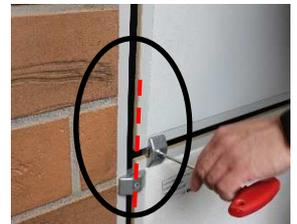
22. Die vertikale Tafel wird mit der horizontalen Tafel verbunden. Erst dann schließlich noch den zweiten horizontalen Verbinder anziehen.
