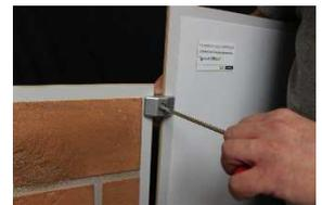
23. Nach dem gleichen Verfahren wird die nächste der horizontalen Tafeln befestigt. In der Kreuzfuge der horizontalen Platten befinden sich vier Verbinder.
